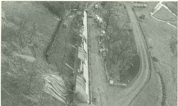
狭隘な施工ヤードの工夫
