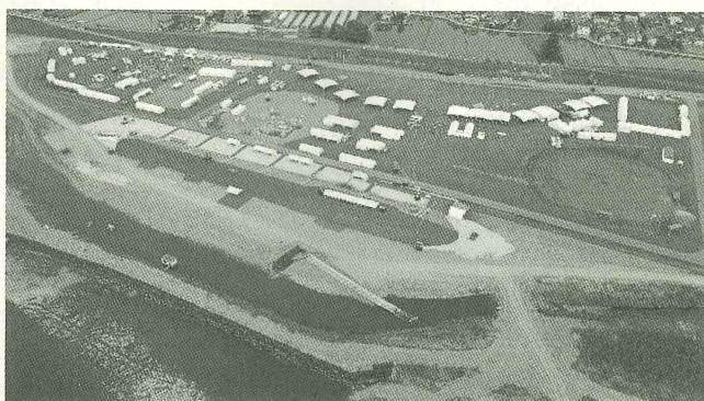
鬼怒川左岸道場宿町地先高水敷整備工事
