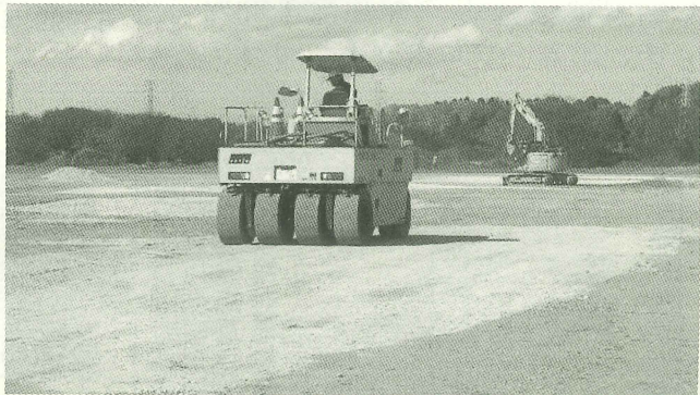
駐車場施工状況
