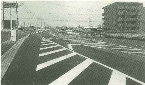
国道4号西那須野道路西三島地区外舗装他工事
